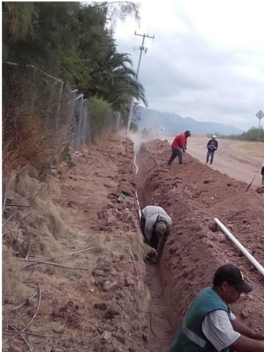
AMPLIACION DE LINEA DE AGUA POTABLE EN SAN JOSE DEL TERREMOTO
