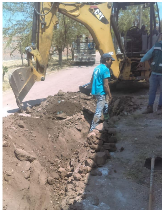
INTRODUCCION DE DESCARGA DE DRENAJE EN CALLE MANUEL GONZALEZ
