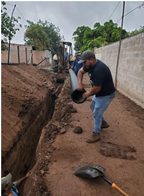
INTRODUCCION DE RED DE DRENAJE SANITARIO EN PRIVADA DE LOPEZ
