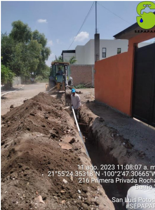
INTRODUCCION DE RED DE AGUA POTABLE EN 2DA PRIVADA DE ROCHA
