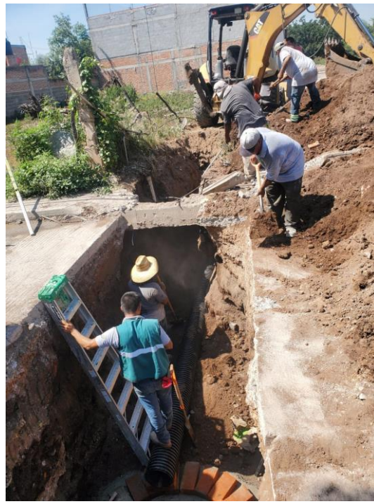
INTRODUCCION DE RED DE DRENAJE SANITARIO EN PRIVADA FAMILIAR DE PORFIRIO DIAZ
