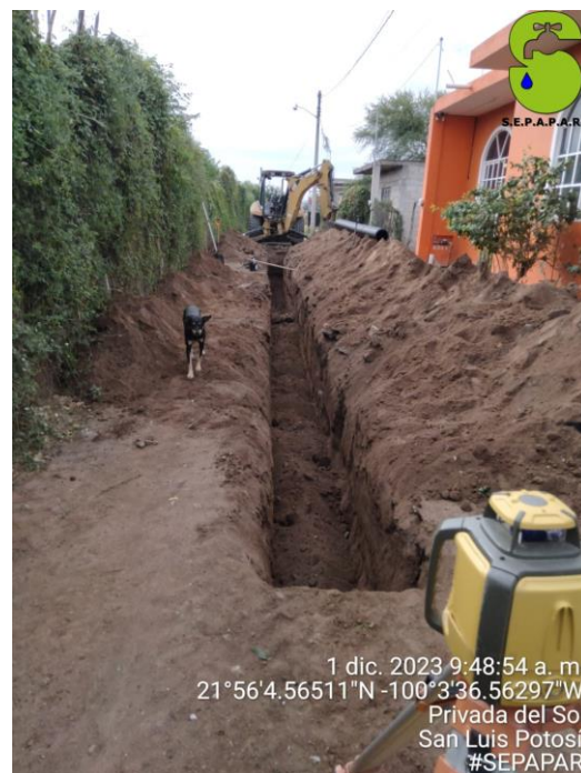
INTRODUCCION DE RED DE ALCANTARILLADO SANITARIO EN 2DA PRIVADA DEL SOL
