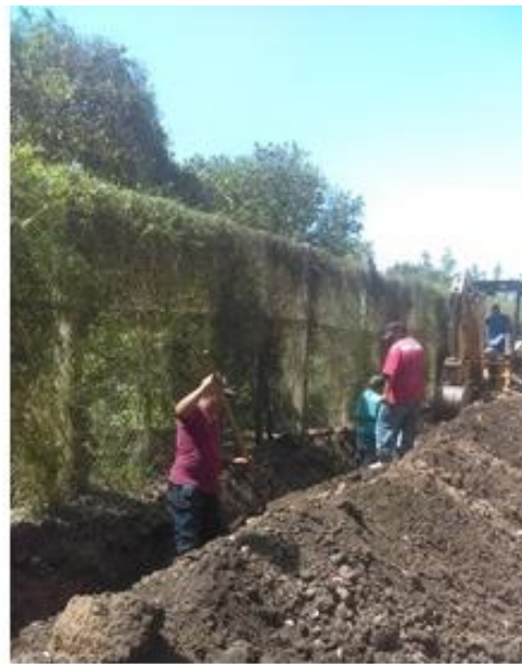
INTRODUCCION DE LINEA DE AGUA POTABLE EN CALLE AZARES
