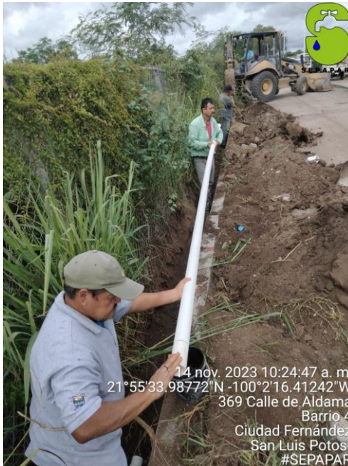
REHABILITACION DE RED DE AGUA POTABLE EN CALLE ALDAMA, BARRIO CUARTO
