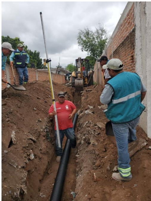
INTRODUCCION DE DESCARGA PLUVIAL EN PRIVADA FAMILIAR DE PORFIRIO DIAZ
