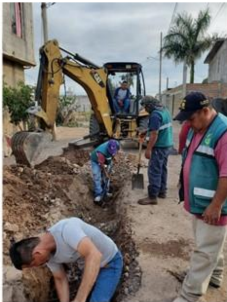
INTRODUCCION DE RED DE DRENAJE SANITARIO EN 1A PRIVADA DE ROCHA
