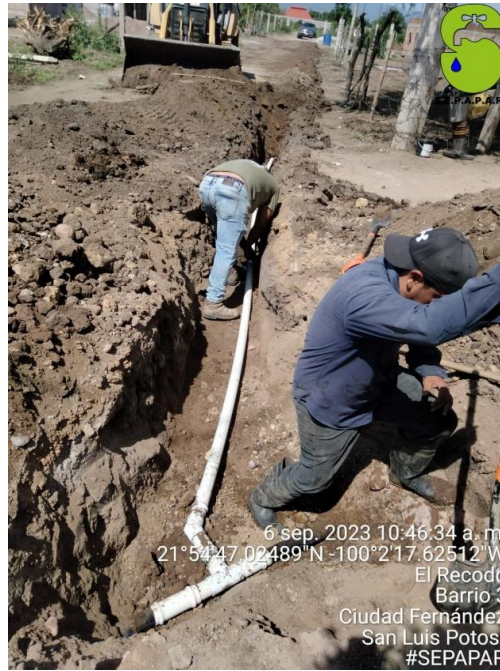
INTRODUCCION DE RED DE AGUA POTABLE EN PRIVADA DEL RECODO
