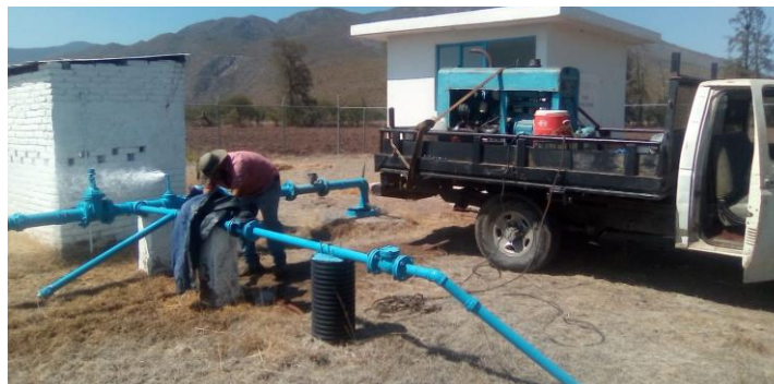
REHABILITACION DE TUBERIA DE SALIDA EN POZO DE RANCHO NUEVO
